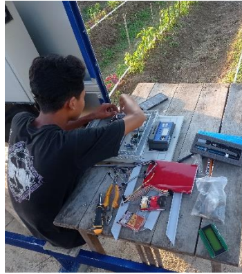
Pengerjaan wiring panel
