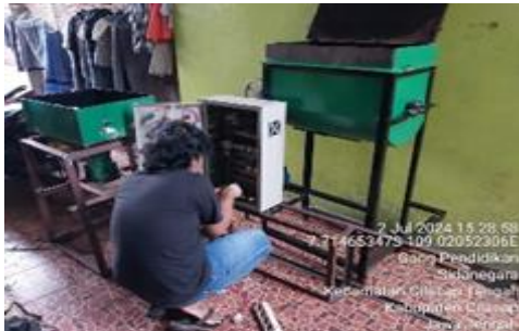
Lampiran 8 Pengerjaan Wiring Panel
