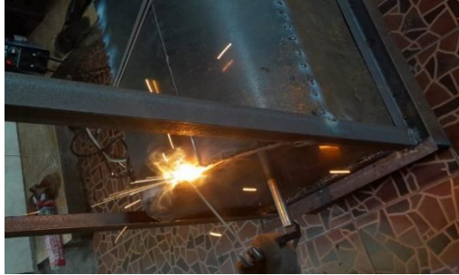
Lampiran 4 Pengerjaan Fabrikasi
