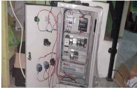
Lampiran 7 Pengerjaan Elektrikal
