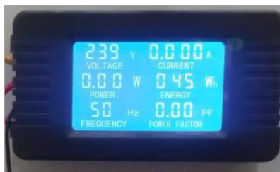
Gambar 4. 26 Pengukuran Rangkaian Instalasi Tanpa Beban
