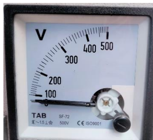
Gambar 2. 14 Volt meter untuk masing-masing fasa
