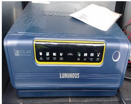
Gambar 2. 7 Inverter (Sumber: Dok. Pribadi, 2023)
