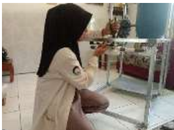
Pemasangan Holder pada Rangka
