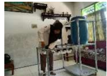
Pemasangan instalasi air
