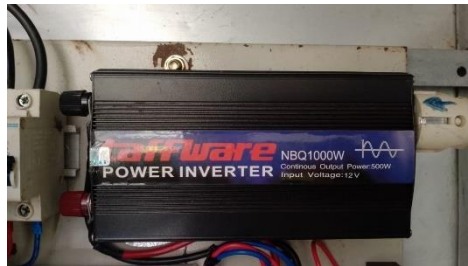
Gambar 2. 4 Inverter (Sumber: Dok. Pribadi, 2023)
