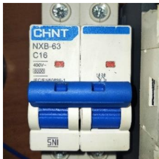
Gambar 2. 7 Miniature Circuit Breaker (Sumber : Dokumen Pribadi, 2023)
