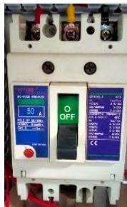
Gambar 2.6 No Fuse Breaker Sumber : Dokumen Pribadi
