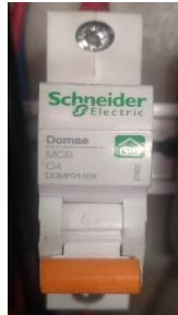
Gambar 2. 7 Miniature Circuit Breaker (MCB) AC (Sumber : Dok. Pribadi, 2023)
