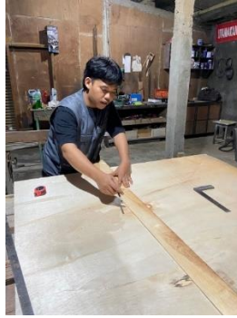
Gambar 1. Proses pengukuran dan pemotongan triplek
