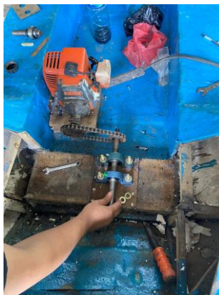
Gambar 15. Proses pemasangan poros transmisi
