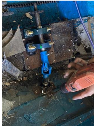
Gambar 16. Proses pengeboranudukan bearing
