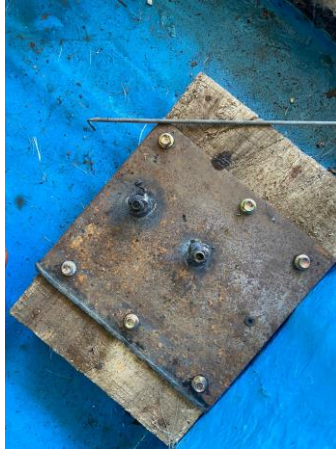
Gambar 13. Proses pemasanganudukan mesin
