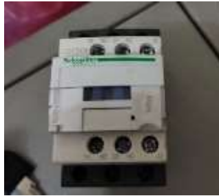
Gambar 2.3 Kontaktor Sumber : Dokumentasi Pribadi
