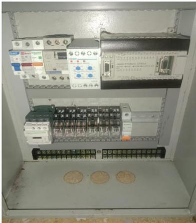
Penempatan komponen didalam panel
