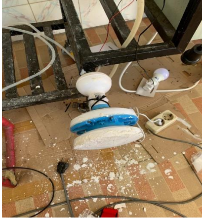
Pemasangan gypsum untuk Penyeimbang kipas.
