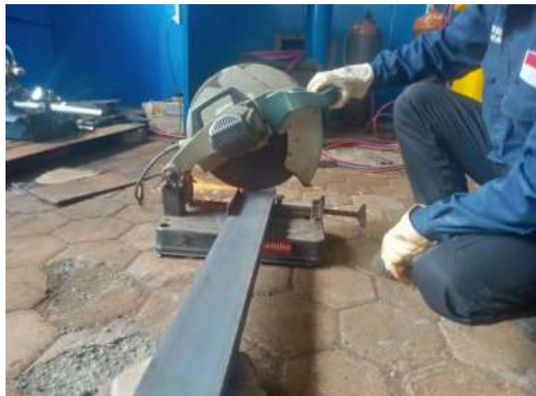
Gambar Proses pemotongan besi kanal U100 (Dokumentasi : Politeknik Negeri Cilacap, 2022)
