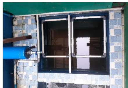
Kondisi kolam tampak atas
