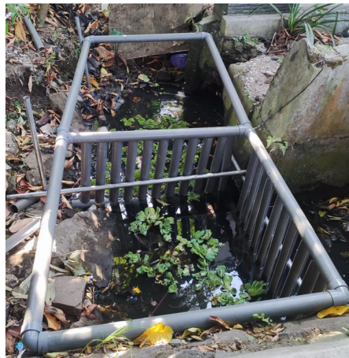
Implementasi desain sekat pada penampungan air limbah Politeknik Negeri Cilacap
