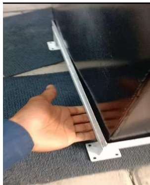
Gambar 9 Uji kebocoran reservoir dengan mengamati dan meraba sambungan las
