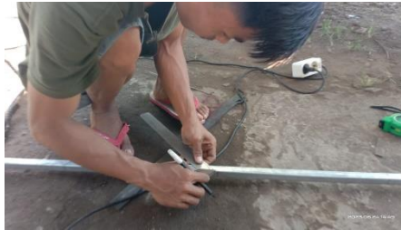
Gambar 1 Proses pengukuran dan pemotongan bahan rangka
